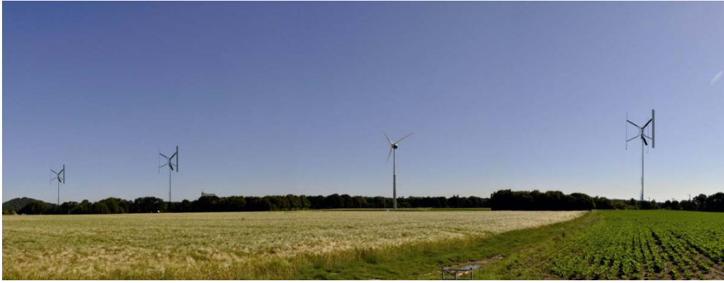
Fotomontage: Kleinwindenergieanlage an der Wasserpumpstation Restrauch/Wiedbusch der NEW AG
