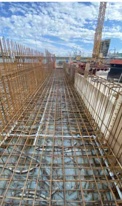
Der Rohbau der neuen Gebläsehalle 2 ist mittlerweile abgeschlossen. Nun arbeiten die Ausbaugewerke in mehreren Bereichen gleichzeitig.
