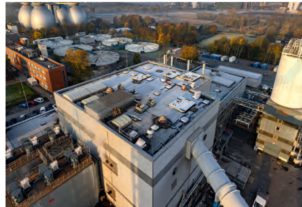
Monoklärschlammverbrennungsanlage der Emscher-Genossenschaft am Standort Bottrop
