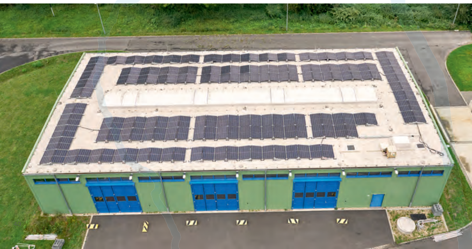
Photovoltaikanlage auf einer Lagerhalle in Mönchengladbach-Neuwerk
