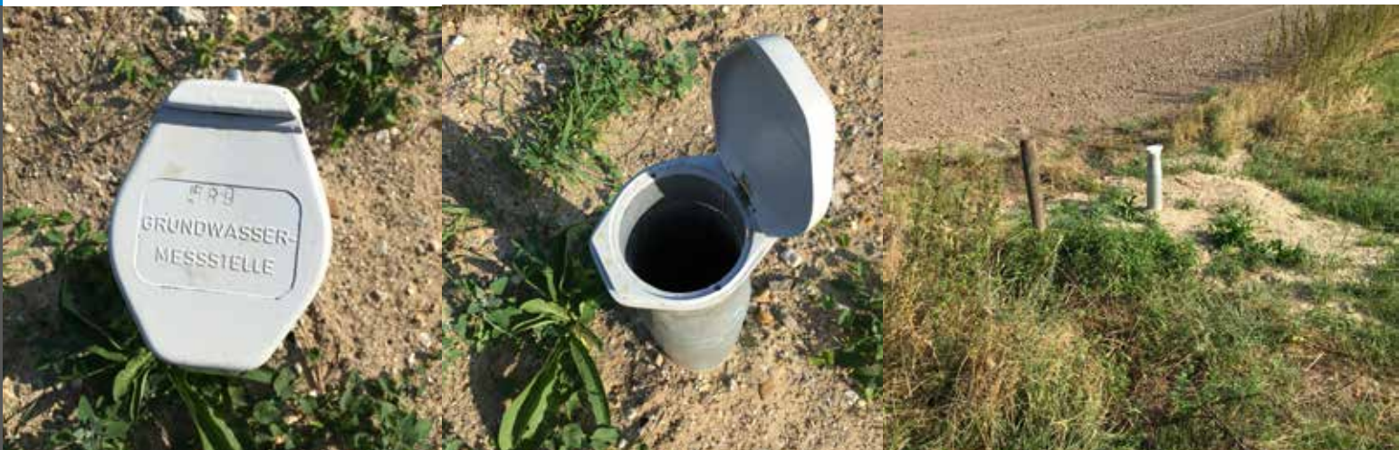
Neu errichtete Grundwassermessstelle
