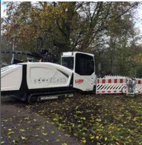
Spülbohrungen am Hochwasserrückhaltebecken (HRB) Nierssee
