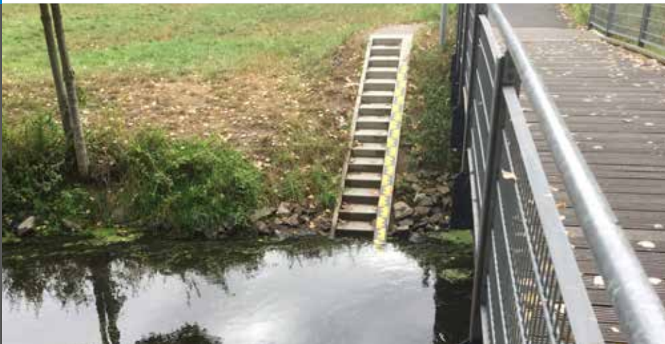
Pegel Hetzert an der Niers mit Pegellatte, Pegelrohr und Treppe
