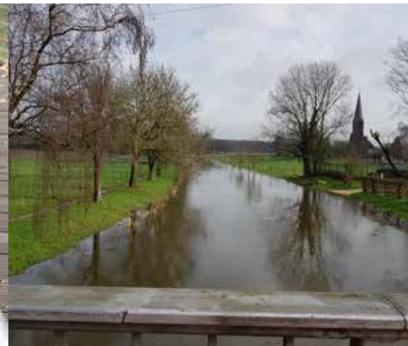
Pegel Kessel, Messstrecke bei Hochwasser im Februar 2020
