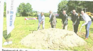
Spatenstich für die neue Pumpstation
