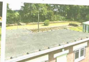
Bald Geschichte: die alte Kläranlage in Wetten
